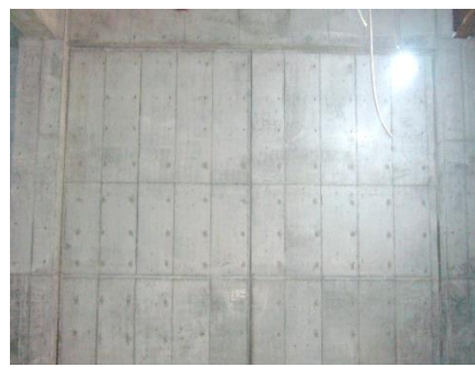
壁の仕上がり状態
